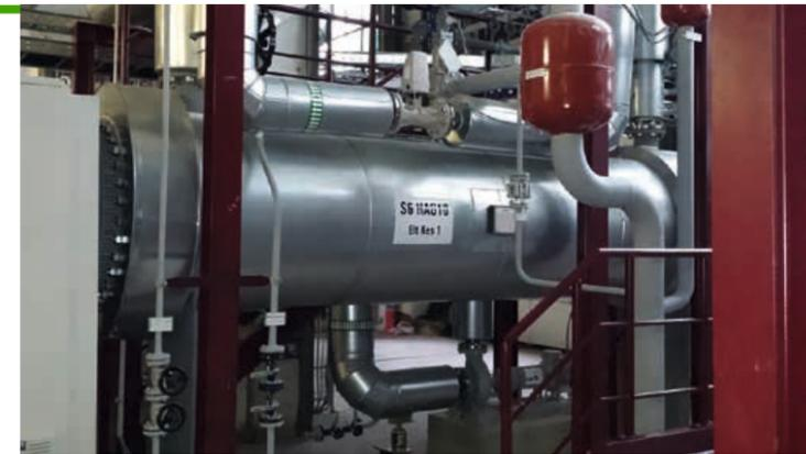
Die Power-To-Heat Anlage der Stadtwerke Schwerin wandelt überschüssige Strommengen elektrisch in Wärme um. Die Stadtwerke Schwerin gehören mit der Inbetriebnahme der drei Elektrokessel am Energiestandort in der Pampower Straße zu den ersten Nutzern Deutschlands, die diese Form der Energiespeicherung zur Entlastung und Absicherung des Stromnetzes anwenden.
